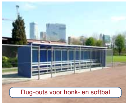
Dug-out met semi-transparant polycarbonaat
