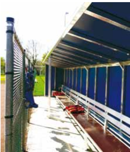
Dug-out met aluminium onderzijde
